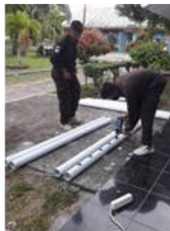
Gambar 4. Proses pemotongan pipa untuk pembuatan instalasi aquaponic
